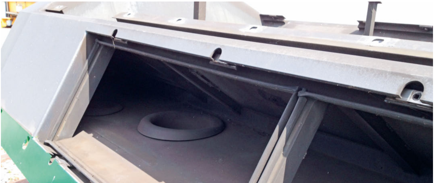
Das Dach der Lokomotive wird für die Wartung demontiert. Gut sichtbar der ursprüngliche Dichtungsrahmen für die Filtergitter, der auf die Länge zugeschnitten und in den Ecken verklebt werden musste.
