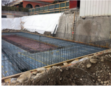
Je nach Flächenpressung wird die passende APSOPUR® Isolationsmatte verlegt.
